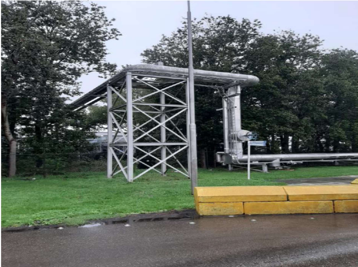
Voorbeeld van een leidingbrug, zoals momenteel aanwezig op het Attero terrein.
